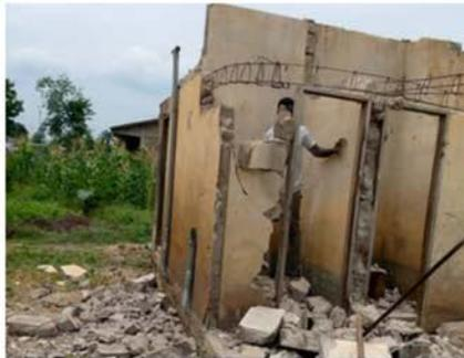
die Latrine baufällig geworden und teilweise eingestürzt. Sie musste abgerissen werden (Bild aus 2024), die Grube ist aber noch zu gebrau-
